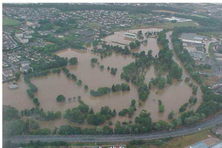
Crue de juillet 2001 – La plaine des jeux de Tujac à Brive-la-Gaillarde. Source : Préfecture de la Corrèze
